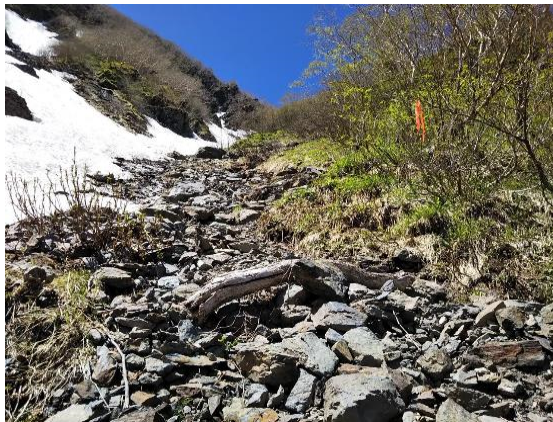
7 撮影日 6月17日(日) 備考 大樺沢上部尾根取り付き箇所 登山道が崩れ、ありません。
